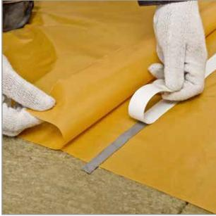
Проклеить стыки в местах перехлеста полотен пароизоляции.
