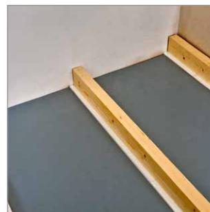
При устройстве пола в виде бетонной плиты перекрытия необходимо произвести раскладку лаг по основанию пола. Рекомендуемое расстояние между лагами — 600 мм по осям. Рекомендуемое расстояние в свету должно быть 580–590 мм.
