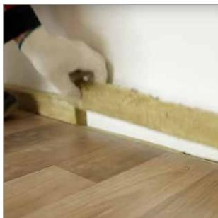
Таким образом между стеной и стяжкой пола образуется демпферная прослойка, которая будет препятствовать распространению звуковой волны от пола на стену.
