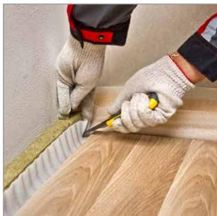
Выступающие части полос из плит ТЕХНОФЛОР необходимо подрезать на высоту чернового покрытия пола. Таким образом, чтобы демпферная прослойка была образована между сборной или полусухой стяжкой. В случае, если демпферный слой подрезается в уровень чистового пола следует заранее предусмотреть соответствующий элемент для закрывания зазора такой ширины. Ширина зазора = толщине плиты.
