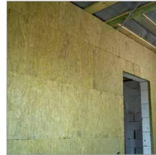
Зазоры в межшовном пространстве между плитами каменной ваты не допускаются, швы заполняются фрагментами ваты. Примыкания звукоизоляционных плит к перекрытиям и стенам заполняются ватой или заполняются клеем-пенной. Срок окончательной полимеризации клея-пены составляет 60 минут, после чего приступают к обшивке листовым материалом.
