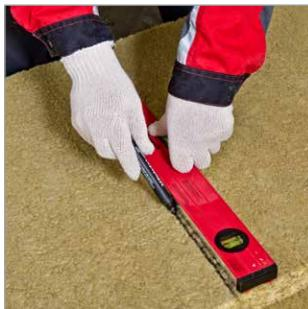
Необходимо измерить расстояние между лагами и отметить необходимую величину на плите ТЕХНОАКУСТИК. Разметку выполняют при помощи маркера. В случае, если шаг между лагами не соответствует 580–590 мм, размер плиты следует выдержать на 10–20 мм больше, чем расстояние между лагами.
