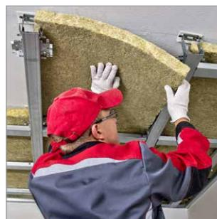
Плиты ТЕХНОАКУСТИК монтировать последовательно, без дополнительного крепления, благодаря ширине 600 мм, они плотно устанавливаются между профилями враспор.
