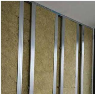
При устройстве облицовки сборка каркаса выполняется, согласно правилам изложенным выше, при этом облицовка устанавливается на минимальном отnose от стены в 20 мм.
