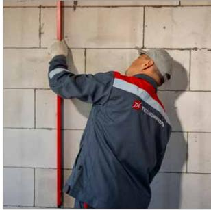
При помощи строительного уровня или правила определить самые выгнутые части стен и общую кривизну стен.
