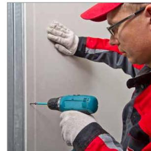
Прижать ГКЛ к каркасу из профилей. Закрепить ГКЛ или ГВЛ на каркасе самонарезающими винтами для ГКЛ или ГВЛ соответственно. ГКЛ необходимо крепить к профилю с помощью саморезов длиной 25 мм, диаметром 3,5 мм, с шагом не более 250 мм.
