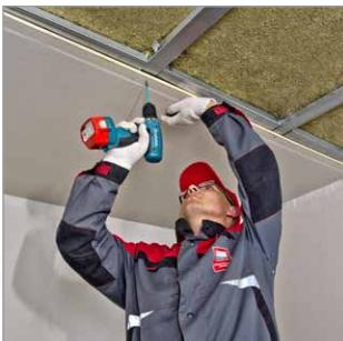
Монтаж начинать цельным листом гипсокартона шириной 1200 мм при помощи саморезов 3,5 × 25 мм с мелкой резьбой.
