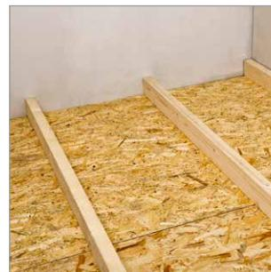
До начала работ по тепло-, звуко-изоляции существующей конструкции перекрытия по деревянным лагам необходимо выполнить обшивку потолка нижележащего этажа ГКЛ, ГВЛ, листами OSB или деревянными досками.
