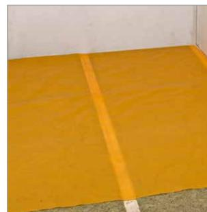
Расположить пароизоляционную пленку поверх плит ТЕХНОАКУСТИК и прикрепить ее к лагам с помощью строительного степлера. Необходимо соблюдать нахлест полотен пароизоляционной пленки не менее 100 мм. Швы следует проклеить двусторонним скотчем.
