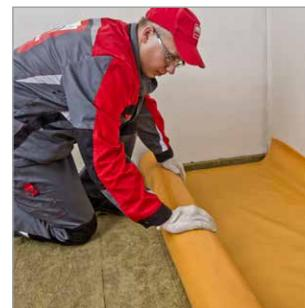
Уложить влагозащитную полиэтиленовую пленку поверх плит с нахлестом на стены и перехлестом полотен между собой 100–150 мм.
