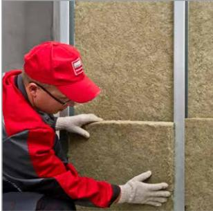
При укладке плит ТЕХНО-АКУСТИК в два слоя следует соблюсти перехлест полотен смежных плит. То есть стыки плит предыдущего слоя должны перекрываться целой плитой последующего слоя.
