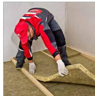
При укладке второго слоя плит необходимо соблюсти разбежку швов и уложить плиты со сдвигом относительно первого слоя.
