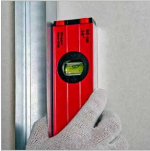
Точность установки следует проверить с помощью строительного уровня.
