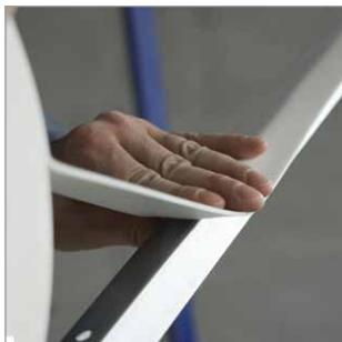
На примыкающую к стене плоскость профиля приклеить виброизоляционную ленту.
