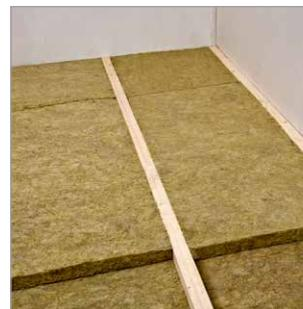
**ВАЖНО!** Избегайте перемещения по звукоизоляционным плитам, используйте для этого подкладки или лаги.
