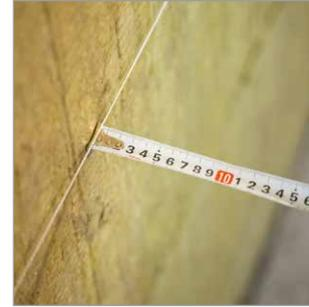
Ввиду незначительного расширения клея-пены в пределах 1-3 мм, плита каменной ваты устанавливается на глубину расширения клея-пены относительно шнура.
