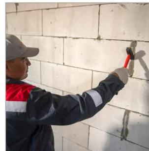
Перед началом работ по звукоизоляции конструкцию проверить на несущую способность, а также на вертикальность при помощи строительного уровня. Кривизна всей плоскости основания не должна превышать более 10 мм. Если кривизна стены превышает 10 мм, то применяется каркасная технология монтажа ТН-СТЕНА Акустик.
