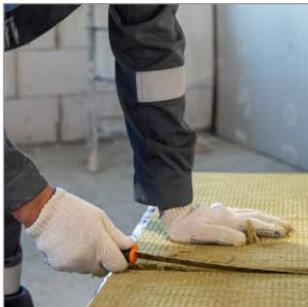
Плиты ТЕХНОАКУСТИК PROF монтировать горизонтально, вплотную друг к другу с осуществлением перевязки швов 1/2, но не менее 150 мм. Подготовленную к монтажу плиту устанавливать в монтажное положение осуществляя лёгкий прижим к стене.
