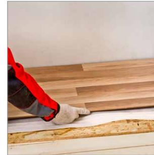
Выполнить монтаж чистового покрытия пола (например, уложить ламинат по подложке или паркетную доску).
