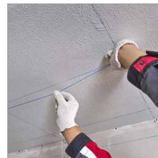
При помощи лазерного строительного уровня и/или отбивочного шнура на стенах с необходимым отступом от потолка обозначить **горизонтальная линия** для последующего монтажа направляющего профиля. На потолке с шагом 600 мм выполнить разметку для крепления подвесов и профилей. Дополнительно между стеной и первым/
