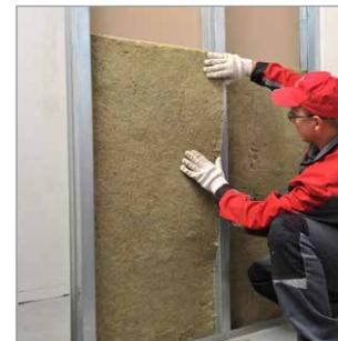
Установить плиты ТЕХНОАКУСТИК в конструкцию. Плита должна заполнить все пространство между профилями, включая углы и места примыкания к полу, стенам и потолку.
