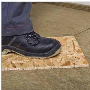
При необходимости передвижения по плитам ТЕХНОФЛОР используются подкладки из сплошного основания.
