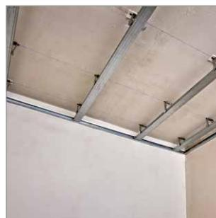
Потолочный профиль крепится к направляющему заклепками или саморезами с обеих сторон. Шаг установки профиля — 600 мм. Для упрочнения системы установить второй ряд профилей перпендикулярно первому. Соединение производить специальными соединителями профилей (одно- или двухуровневыми).
