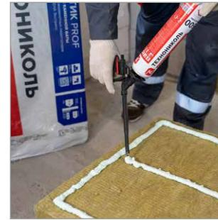
Перед нанесением клея-пены баллон тщательно встряхнуть в течение 30 секунд, устанавливается в пистолет и стравить небольшое количество клея-пены.
