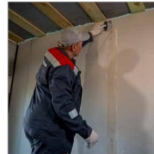
Для предотвращения появления трещин при отделочных работах в местах стыка листов облицовки применять специальную армирующую ленту. Лента зашпаклевывать в шов между листами.
