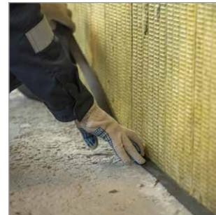
Монтаж выполнить целыми листами ГКЛ/ГВЛ в один или два слоя на высоту этажа. Толщина одного слоя 12,5 мм. Для отсеечения структурных вибраций от основания, на пол уложить виброизоляционная лента.
