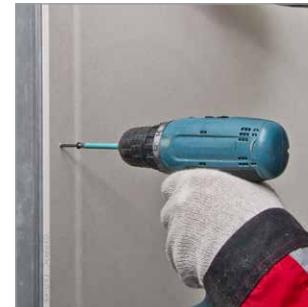
Закрепить ГКЛ или ГВЛ на каркасе при помощи саморезов.
