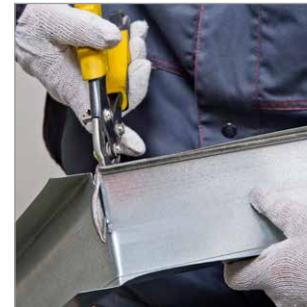
Нарезку металлического профиля выполнить с учетом установки в конструкцию.
