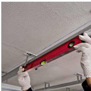
Согласно разметке установить подвесы с шагом 400–1200 мм в зависимости от веса листового материала и уровней подвесного потолка.
