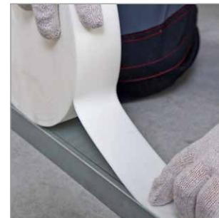
Приклеить уплотнительную полиуретановую ленту на полку направляющего профиля. Установка ленты предотвратит распространение шума через конструкцию в процессе эксплуатации.
