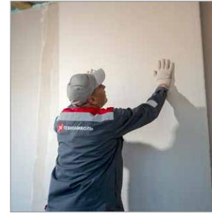
Крепление второго и далее листов осуществлять либо клеевым способом (при помощи клея-пены), либо механическим способом (при помощи саморезов) друг к другу, корректируя плоскость.
