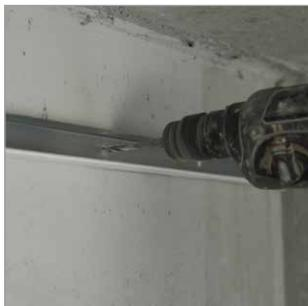
Согласно размеченным осям направляющий профиль закрепить по периметру с шагом 500 мм.
