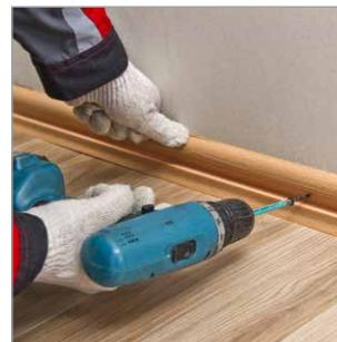
Закреть зазор при помощи напольного плинтуса.
