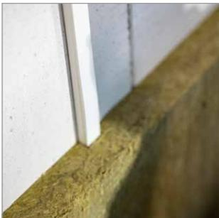
В случае установки электропроводки в кабель-каналах поверх существующей стены на внутренней поверхности плит каменной ваты вырезаются соответствующие борозды по размеру и длине перед монтажом. Корректировка положения плиты возможна в течение 2 минут после первого прижима, но не позднее 5 минут после нанесения клея-пены.
