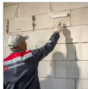
Очистить стены, пол и потолок от существующей чистовой отделки, пыли, жировых пятен и грязи в местах расположения обшивки. Основание не должно пылить. Для слабых и пылеватых поверхностей обязательно провести грунтование.
