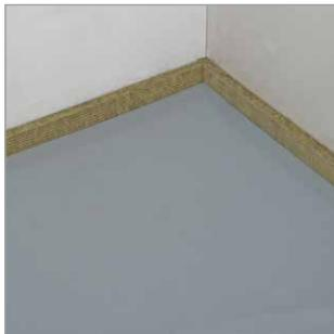
В местах сопряжения с другими конструкциями (стенами, перегородками, трубопроводами, проходящими через перекрытие, и т.д.) необходимо установить полосы, нарезанные из плит ТЕХНОФЛОР, высотой до финишного покрытия пола.
