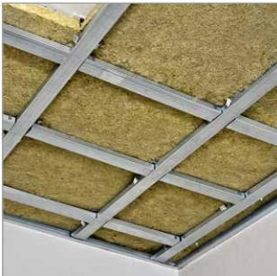
Для упрочнения системы установить второй ряд профилей перпендикулярно первому с шагом 1200 мм. Во избежание провисания плит каменной ваты возле стены, с отступом 100 мм выполнить дополнительный усиливающий поперечный ряд профилей. Соединение производить специальными соединителями профилей (одно- или двухуровневыми).
