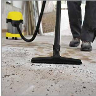
К началу работ по тепловой и звуковой изоляции помещения все мокрые процессы в помещении должны быть завершены. Необходимо механическим способом очистить стены, пол и потолок в местах расположения перегородки от грязи и пыли.
