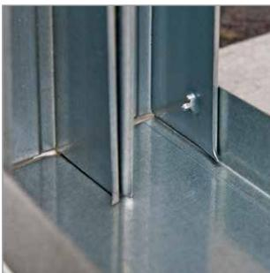
Выполнить фиксацию стоечного профиля к направляющему с помощью просекателя.
