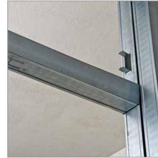
Установить перемычки для дверных проемов. Горизонтальные перемычки для стабилизации положения плит из каменной ваты ТЕХНОНИКОЛЬ необходимо предусматривать каждые 4 метра по высоте конструкции.
