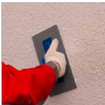
Наносят защитно-декоративную штукатурку слоем в размер зерна и сразу растирают круговыми движениями. Наносить декоративную штукатурку необходимо одинаковым движением, зависящим от той текстуры, которая нужна. Работать рекомендуется одинаковыми терками.
