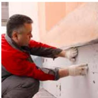
Теплоизоляцию цоколя выше уровня земли следует выполнять в соответствии с проектом на высоту не менее 1200 мм. В качестве теплоизоляционного слоя выше уровня земли возможно использовать специальную марку экструзионного пенополистирола ТЕХНОНИКОЛЬ CARBON ECO FAS, которая выпускается с фрезерованной поверхностью, обеспечивающей лучшую адгезию клеевых составов. Также возможно использовать другие марки XPS ТЕХНОНИКОЛЬ CARBON PROF/ECO с гладкой поверхностью. В этом случае для улучшения адгезии
