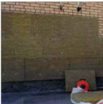
На углах здания можно укладывать только целые и половинные изоляционные плиты. Пригоночные детали  $\geq 150$  мм из одного и того же изоляционного материала можно использовать только на рядовой зоне и ни в коем случае на краях. Промокшие или поврежденные плиты устанавливать нельзя.
