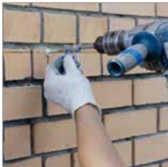
Перед началом установки крепежных изделий выбранный в соответствии с типом стены дюбель забивают в отверстие.
