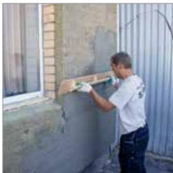
После механического нанесения штукатурный раствор разглаживают правилом, слегка придавливая к теплоизоляции.
