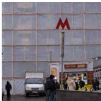
Рекомендуется производить работы при среднесуточной температуре от +5 до +30 °С и скорости ветра менее 10 м/с. При проведении монтажных работ зимой необходимо закрыть строительные леса одним или двумя слоями пленки по всему периметру и установить тепловые пушки для поддержания положительной температуры не ниже +5 °С.
