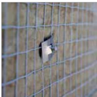
Перед началом установки сетки необходимо убедиться в том, что все крюки, являющиеся составной частью крепежного изделия, выведены из блокировочного положения и установлены под заданным углом не менее 30°. Сетка натягивается полосами, равными ширине рулона. Рулон раскручивается сверху вниз. Нахлест сетки должен составлять не менее 50 мм.
