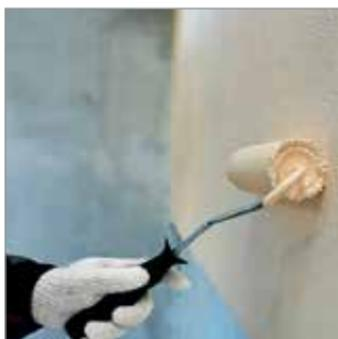
При необходимости поверхность фасада может быть дополнительно окрашена фасадными красками. Но не ранее, чем через 7 дней после монтажа штукатурки. В процессе нанесения и сушки штукатурка должна быть защищена от прямых солнечных лучей, дождя и ветра.
