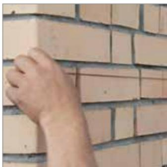
Стену при помощи цветного шнура необходимо разделить на квадраты со стороной 500 мм, начиная от угла и учитывая, что первая линия проводится на расстоянии 150 мм от угла. В местах пересечения линий, где будут сверлиться отверстия крепежа, делаются отчетливые отметки.
