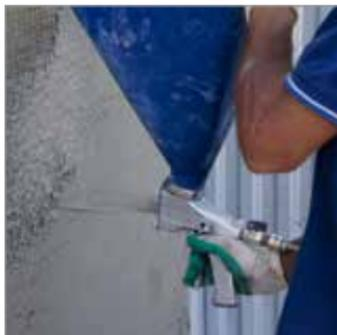
Штукатурный раствор можно наносить механически (растворонасосом) или вручную стальным шпателем, придавливая его к сетке и теплоизоляции. При необходимости сетку оттягивают от минераловатной плиты так, чтобы штукатурный раствор покрывал ее с обеих сторон полностью. Если сетка в некоторых местах вздувается и выпирает из раствора,
