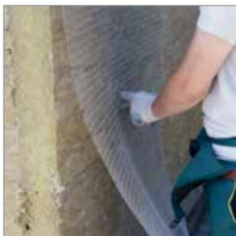
Для облегчения работ по установке сетки от рулона отрезаются куски длиной в 2–3 этажа при помощи специальных ножниц. Сетка натягивается сверху вниз и фиксируется блокировочной шпилькой (или крепится путем установки на каждый крюк двух блокировочных пластинок поверх сетки). Блокировочные шпильки можно снимать и устанавливать
