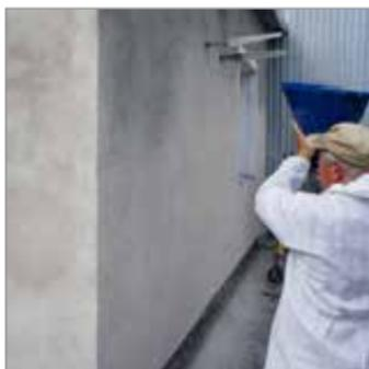
Нанесение защитно-декоративной штукатурки возможно с помощью механизированного оборудования или ручным методом.
