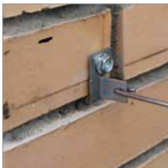
По отметкам устанавливаются скобы, которые крепятся к стене при помощи подходящих крепежных дюбелей. В скобу вставляется маятниковый рычаг, который фиксируется в верхнем положении под углом 90° для легкого монтажа теплоизоляции.
