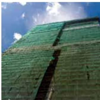
Необходимо защитить монтируемый фасад от атмосферных осадков и от прямых солнечных лучей. Для этого сверху устраивается ограждение, а по периметру леса обтягивают защитной строительной сеткой.
