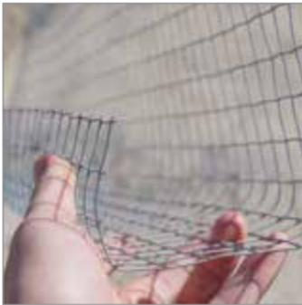
Первый ряд плит из каменной ваты укладывается в желоб из сетки, установленный на линии цоколя. Основная задача стартового профиля из сетки — задать четкую геометрию фасадной системы.
