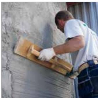
Назначение второго штукатурного слоя — выровнять конструкцию стены и создать прямую и ровную основу для нанесения финишного защитно-декоративного слоя. Расход раствора для второго слоя — 15–20 кг/м<sup>2</sup>.
