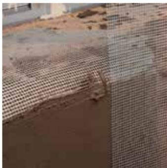
Подготовленный клеевой раствор следует наносить длинной теркой из нержавеющей стали на плиту вертикально, в виде полосы. Толщина клея должна составлять около 3 мм. Раствор наносится начиная от угла здания. После нанесения клеевого раствора на отрезке, равном длине приготовленной сетки, его выравнивают зубчатой стороной терки до получения
