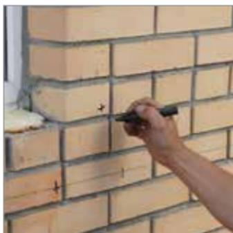
Вокруг оконных, дверных и других проемов места сверления отверстий под крепеж отмечаются отдельно специальным мелком. Отметки делаются на расстоянии 150 мм от краев проема. Сверление отверстий в отмеченных местах начинают, учитывая глубину сверления для крепежных дюбелей.
