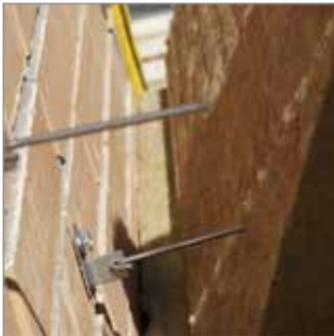
Теплоизоляционные плиты ТЕХНОФАС ЭКСТРА накладываются на установленные в верхнем положении маятниковые рычаги таким образом, чтобы крюки прошли через плиту насквозь. Монтаж плит производится снизу вверх. Установка плит выполняется с зубчатой перемычкой на углах и смещением швов по горизонтали. Вокруг оконных и дверных проемов
